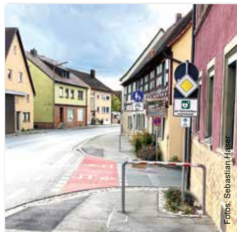
Neue Markierungen von Radverkehrsfurten inklusive rotem Belag über den Kreuzungsbereich in Birkenfeld am Torweg.
