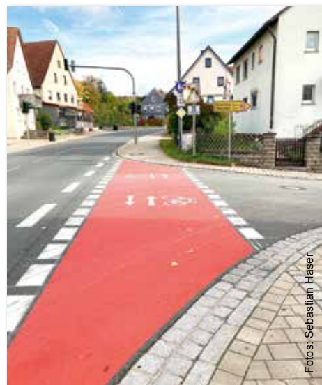
Neue Markierungen von Radverkehrsfurten inklusive rotem Belag über den Kreuzungsbereich in Diebach.
